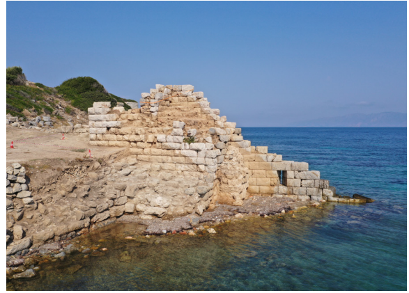
Fig. 6: Liman girişindeki kule, girişi daraltan duvar ve dışa doğru sivrilen 'V' şeklinde mazgal açıklığı (A. Büyüközer).
