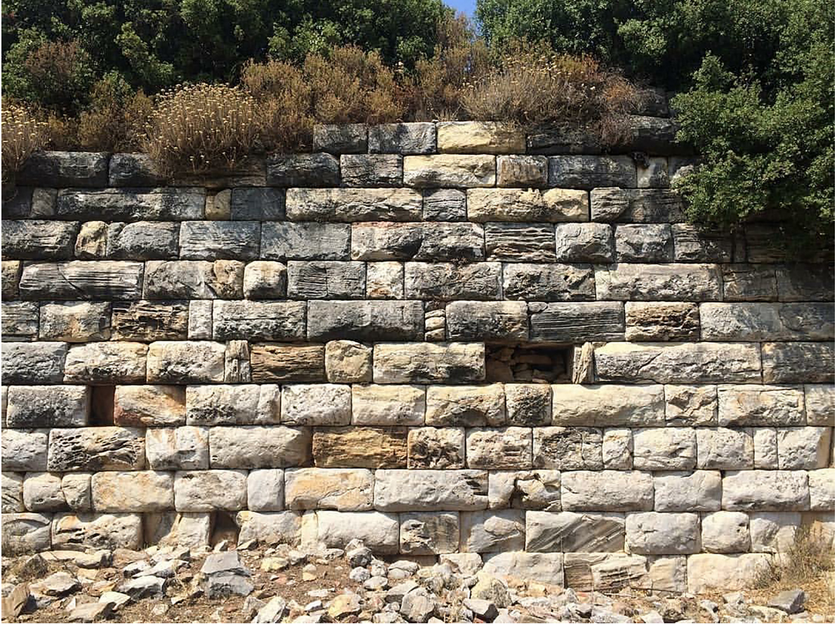
Fig. 2: Amyzon teras duvarındaki uzun dizi ve dar bağ taşlarından oluşan örgü (A. Büyüközer).
