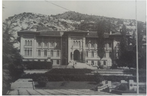
Fot. 1. Kastamonu Hükümet Konağı (Sözen, 1984: 64)
