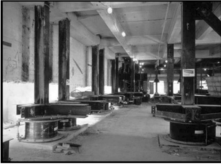
Şekil 14: San Francisco Sanat Müzesi Sismik Yalıtım Uygulaması (URL-5).
