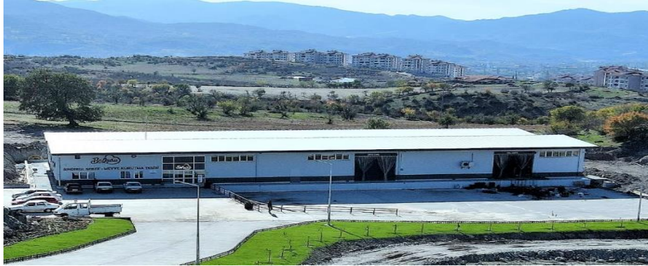
Balkuru Üretim Tesisi
