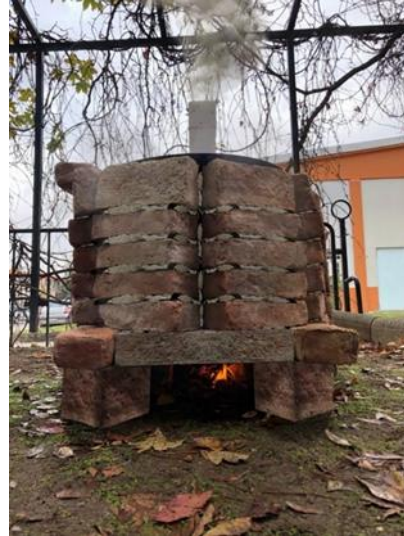
Görsel 8. Fırın yapımının başlangıcı (Fotoğraf: Erdem Aybar)
