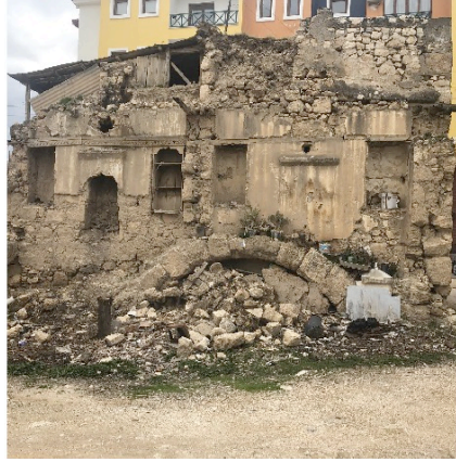
Şekil 5. Saray Mahallesi, Cavid Erden Caddesinde antik kemerler üzerine inşa edilmiş konut örneği (Kaynak: Akyürek Algın, 2021)
