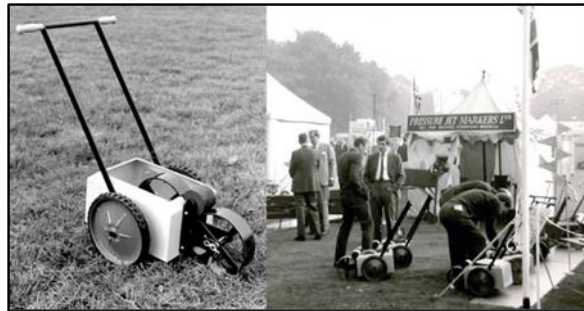
Şekil 3. “The Dimple” tekerlekten tekerleğe (aktarmalı) çizgi işaretleyici (Harrod, 2018)
