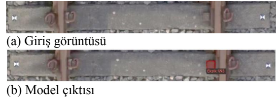
Şekil 10. Eksik bağlantı elemanı hatası model giriş ve çıktı görüntüleri
