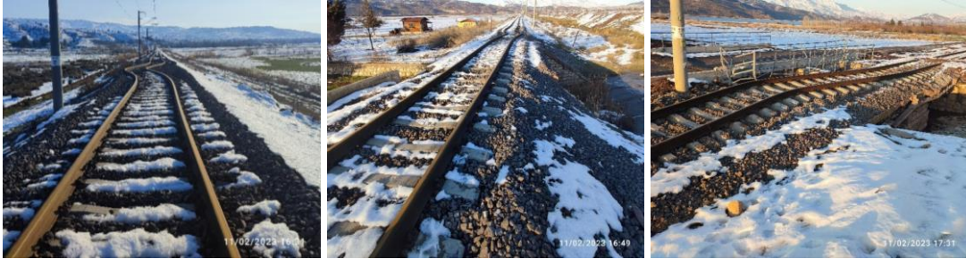
Şekil 6. Menfez bölgelerinde sıkça rastlanılan S-tipi yanal atılım örnekleri
