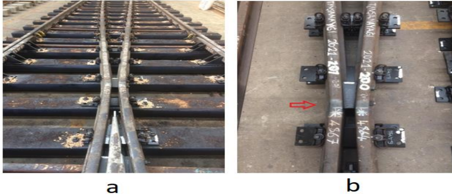
Şekil 4. Demiryolu makası tavşan ayakları; a) Makas göbeğinde tavşan ayaklarının pozisyonu, b) Tavşan ayaklarının pres bölgelerinin gösterilmesi [6]
