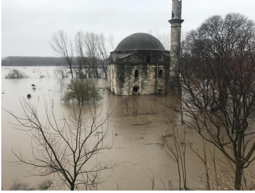
Şekil 1. Tunca nehri kıyısında bulunan ve taşkın altında kalan Kasımpaşa Camii.
