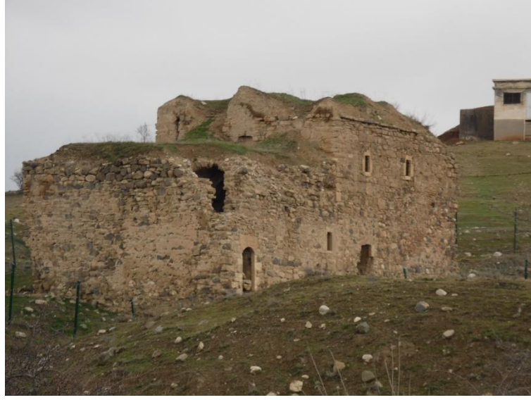
Şekil 6. Güneydoğu ve güneybatı cephesine ait perspektif görüntüsü (2019).
