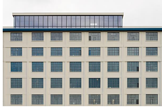
Şekil 24. Eiffel Building dış cephe (Url 30, 2022)
