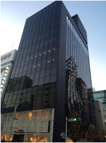
Şekil 9. Tokyo Chanel Ginza Binası gündüz görünümü
