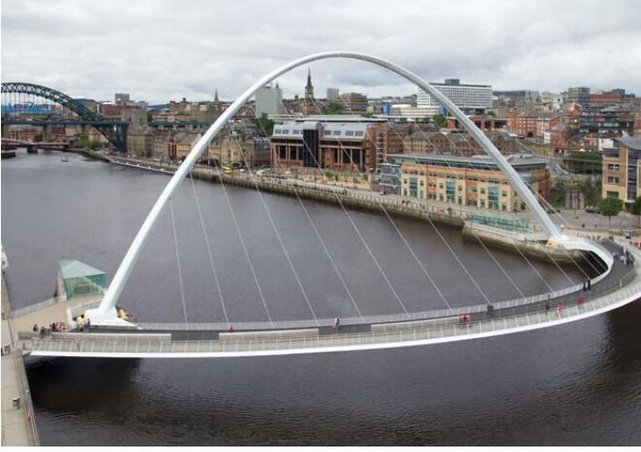
Şekil 3. Gateshead Milenyum Köprüsünün genel görünüm
