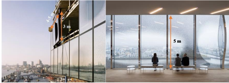
Şekil 21. Cam cephe panelleri ve panellerin montajı [21]
