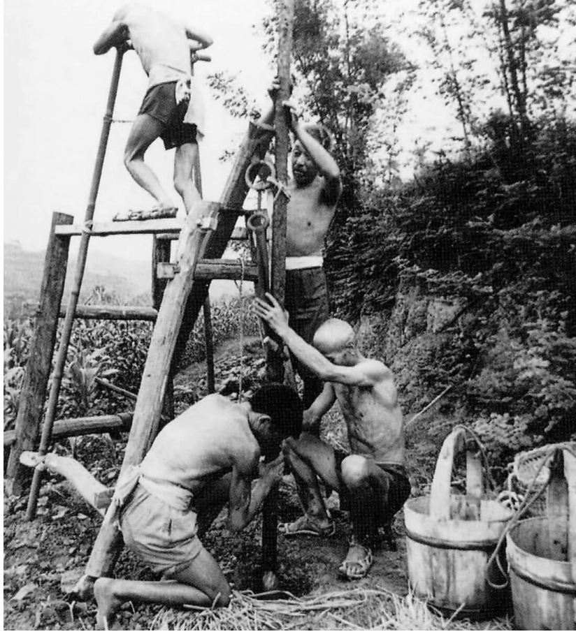
Şekil 2. Kuzey Song Hanedanlığı'ndan (MS 960-1127) Modern Sondaj Tekniği Rekreasyonu. (Kuhn, 2004) (A Modern Recreation Of Sounding Techniques From The Northern Song Dynasty. AD 960-1127)
