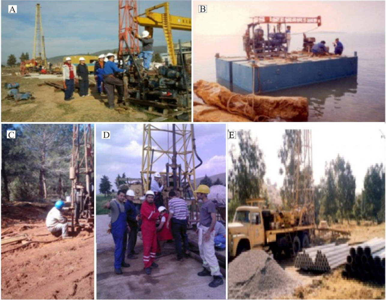
Şekil 6. DEÜ-TMY 1997-20010 Yılları Arası Su Ve Zemin Sondajı Uygulamaları. A Ve D, DEÜ-TMY Kampüsü İçinde Eğitim Amaçlı Su Sondajı Uygulaması. B, Duba Üzerine Yerleştirilen Sığ Deniz Zemin Sondajı. C, Özel Sektör İçin Yapılan Zemin Sondajı. E, Özel Sektör İçin Yapılan Su Sondajı (Water And Soil Drilling Applications Between DEÜ-TMY 1997-20010. A And D, Water-Drilling Application For Educational Purposes In DEÜ-TMY Campus. B, Shallow Offshore Soil Drilling Placed On The Pontoon. C, Soil Drilling For The Private Sector. E, Water Drilling For The Private Sector)
