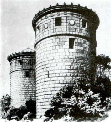
Res. 56 — Perge şehir kapısı kulelerinin eski hali (Lanckoronski I, res. 48).
