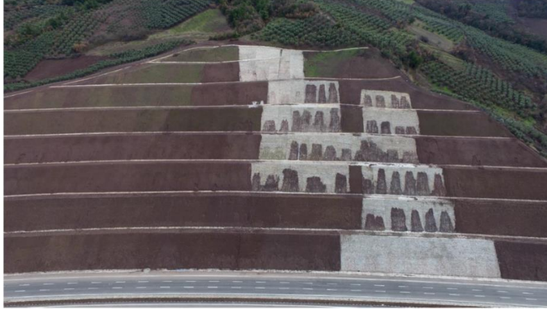
Şekil 4. Yarma şevlerinde taş dolguda gözlemlenen deformasyonlar
