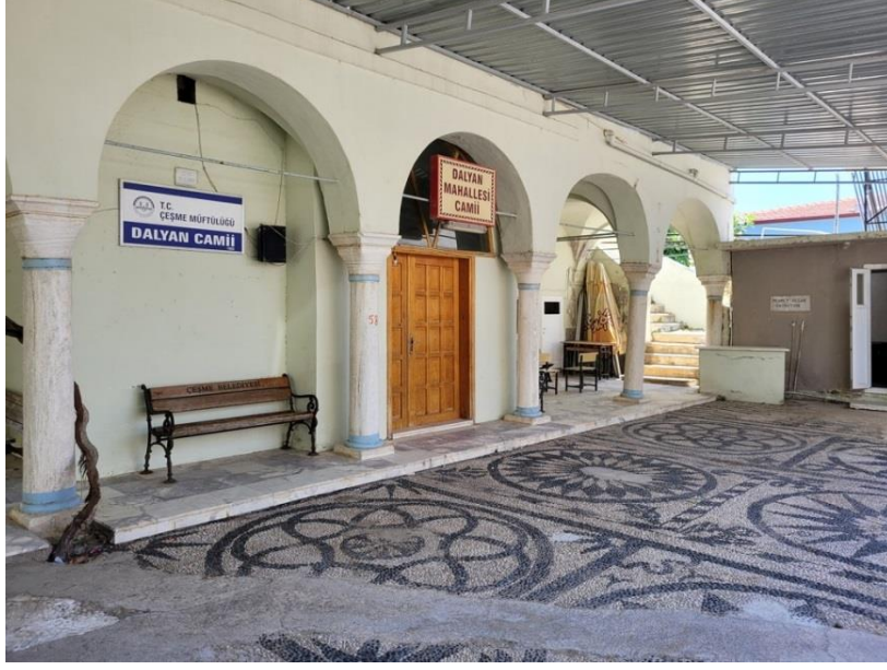
Fot 3. Dalyan Mahallesi Camii Batı Cephesi
