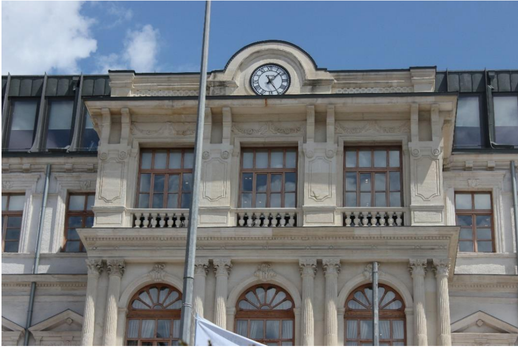
Foto. 5: Ana cephe çatı seviyesindeki parapet duvarın merkezinde yer alan saat kadranı
