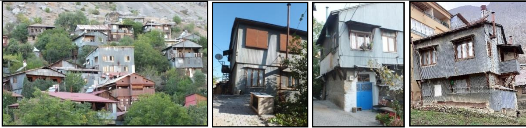
Görsel 2. Kemaliye'de yetme katının kapatılarak cephelerin sac ile kaplanması.
