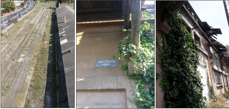
Görsel 11. Yapı bloğunun çevresinde görülen bitkilenmeler (Yazar, 2020; bu görseller yazarlar tarafından çekilmiştir)
