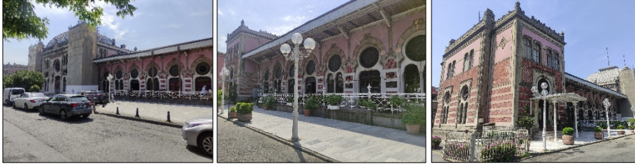
Görsel 2. 1890 tarihli Sirkeci Gar Binası (Yazar, 2022; bu görseller yazarlar tarafından çekilmiştir)
