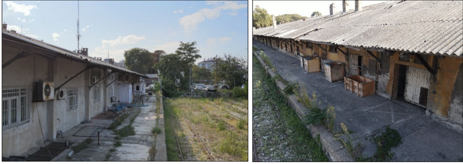
Görsel 4. Gümrük (sol) ve ambar binası (sağ) kuzey cephesi (Yazar, 2020; bu görseller yazarlar tarafından çekilmiştir)
