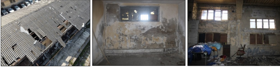
Görsel 8. Gümrük binası çatı örtüsü ve ambar binası iç mekân mahalleri (Yazar, 2020; bu görseller yazarlar tarafından çekilmiştir)
