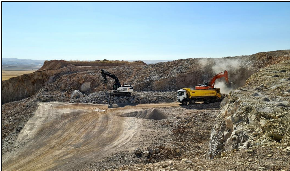
Şekil 1. Taş ocağında yapılan üretim faaliyetine ait görüntü.
