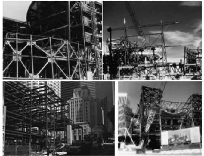
Resim 18. Çelik Strüktür Kurulum Aşamaları ("Los Angeles Public Library Photo Collection," 2021)
