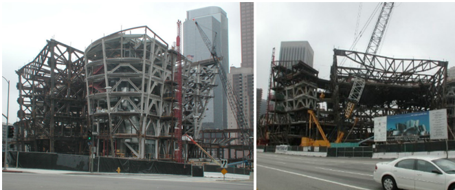
Resim 17. Çelik Strüktür Sistemi Montajı ("Walt Disney Concert Hall, Wikipedia," 2021)
