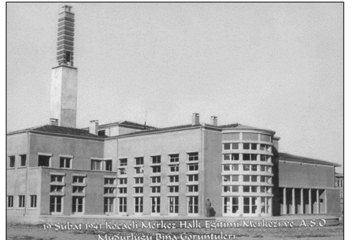
Resim 11. İzmit Halkevi Binası (Url-1).
