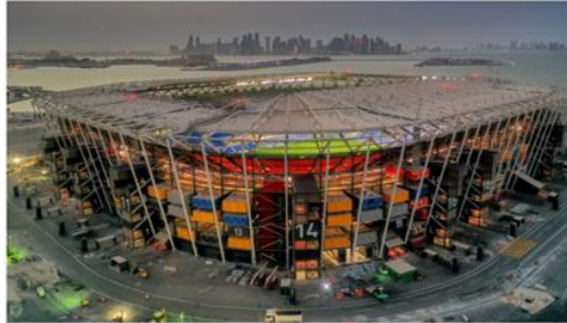
Şekil 3. Konteynerden inşa edilen Stadyum 974 (URL-16, 2021).
