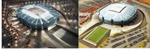
Şekil 1. Phoenix Üniversitesi Stadyumu'nun açılır-kapanır çatısı (Mohamed & Abu Elfadle, 2013).
