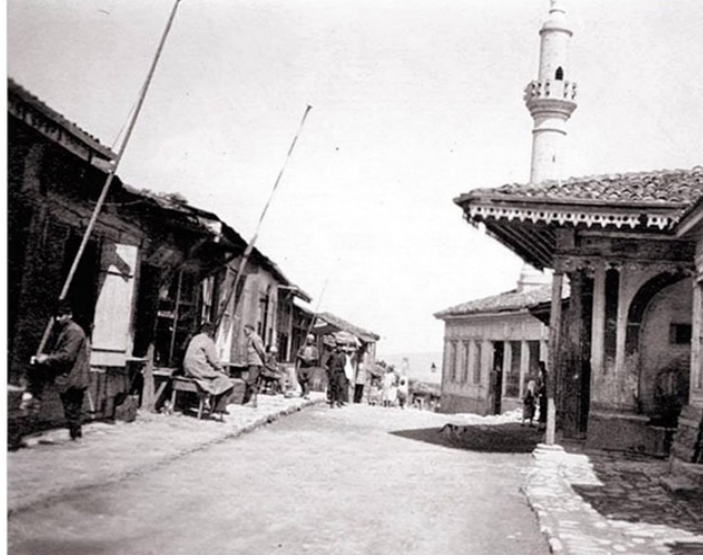
EK 10 Damat Öküz Mehmet Paşa Çeşmesinin Eski Hali
