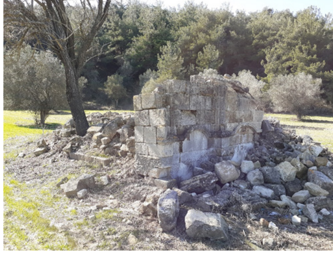
Res.5- Cevat Paşa Çeşmesi (2022)
