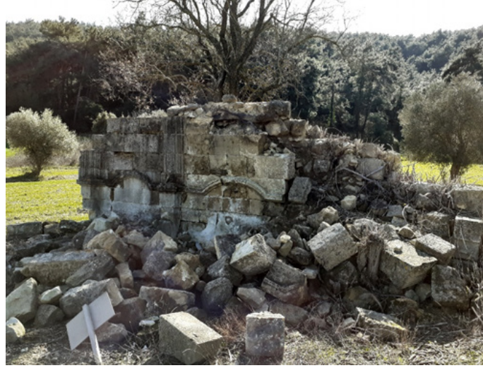
Res.4- Cevat Paşa Çeşmesi (2022)
