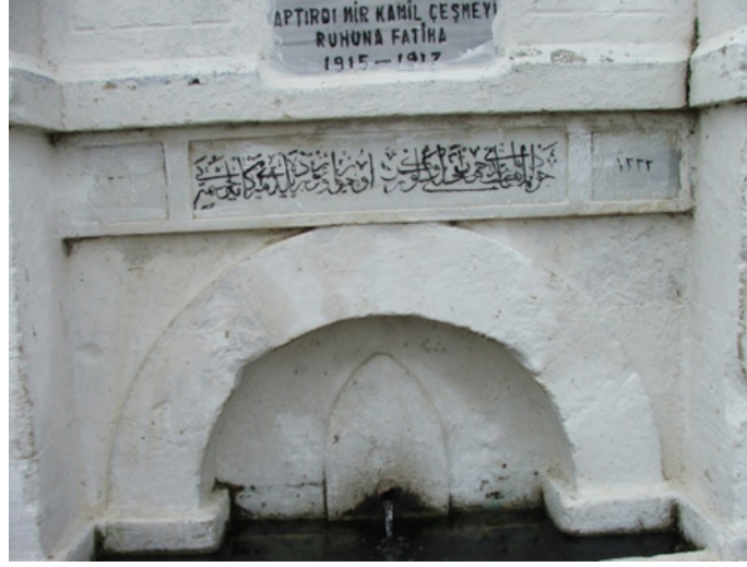
Res.15- Sarıcaeli Cevat Paşa Çeşmesi cephe detayı (2007)
