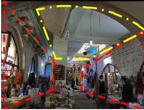
Arasta Kapalı Çarşı: *Sarı alanda eklenti betonarmeler kaldırıldığında iç avlulu, sağda ve solda dükkanlar görülmektedir.*Kırmızı alanlar dükkan olduğu görülmektedir.*Yeşil alanlar; Taş bingi ile üst katta gezinti alanı oluşturulmuş.
