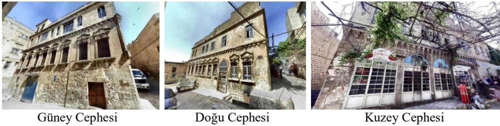
Şekil 4. Yapının güncel durumuna ait cephe görüntüleri
