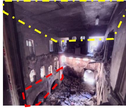
Eski Köşk Sineması: Sarı alanda eklenti betonarmeler kaldırıldığında iç avlulu etrafında odalar görülmektedir.
