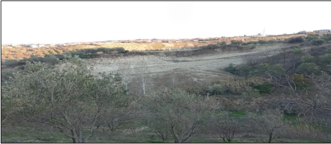
Fotoğraf 5. Tepehan kütle hareketi (heyelanı) öncesi arazide düzleştirme çalışmaları sonucu oluşmuş, arazinin statik dengesini bozan ve heyelanı hazırlayıcı unsurlardan biride tarımsal amaçlı oluşturulan zeytin bahçeleri.
