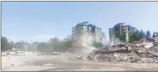
Şekil 2. Deprem sonrası bina yıkımından bir görüntü.
