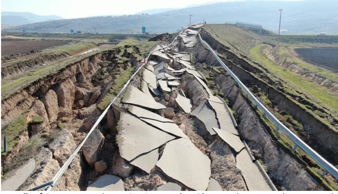
Fotoğraf 2. Tarsus-Adana-Gaziantep (TAG) otoyolu Pazarcık ayrımında bağlantı yolunun tahrip olması (Hürriyet, 2023).
