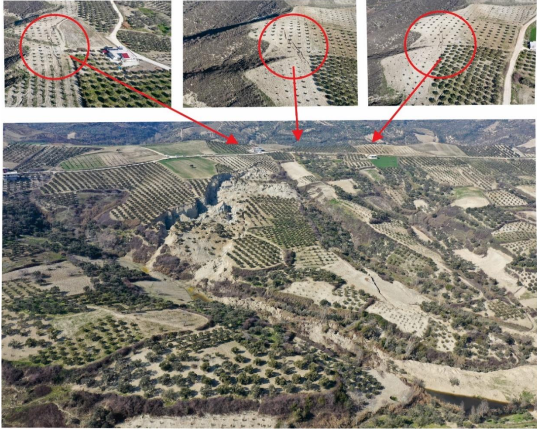
Şekil 7. Heyelanın taç kısmının üst bölümlerinde oluşan uzunluğu yaklaşık 320 m'yi bulan açılma çatlakları 5 .
