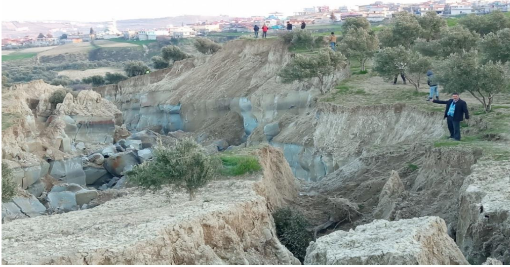
Fotoğraf 3. 6 Şubat Kahramanmaraş depremleri ile Tepehan köyü yakınında oluşan kütle hareketi içerisinde derinliği yer yer 20 m'yi bulan yarıklar (batıya bakış).
