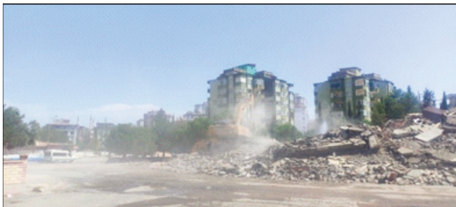
Şekil 3. Deprem sonrası bina yıkımından bir görüntü.
