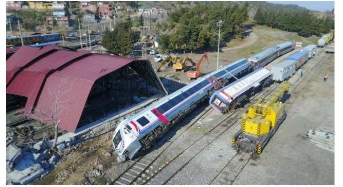
Fotoğraf 5. Fevzipaşa tren istasyonunda devrilen lokomotif ve vagonlar (NTV, 2023a).
