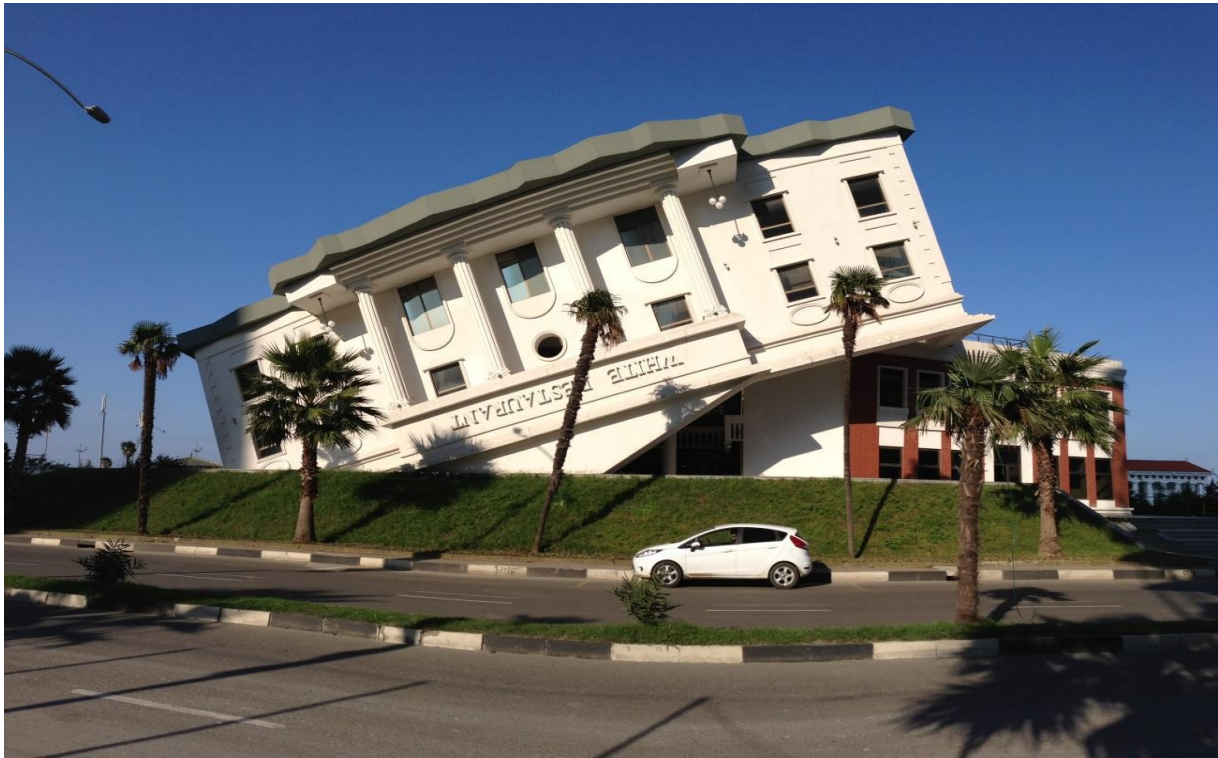
Şekil 5. Postmodern Mimari Örneği - Upside-Down White House Restaurant - Batum
