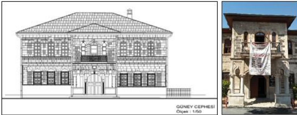
Şekil 7. Ergani Hükümet Konağı güney cephesi (Ağca, 2011) ve dışa çıkmalı kısım fotoğrafı (2022)
