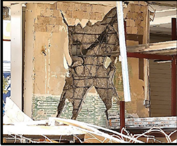
Şekil 1 - 2023 Kahramanmaraş merkezli depremlerde meydana gelen betonarme perde hasarları [1]
