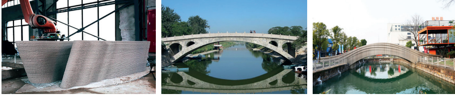
Görsel 18. Anji Köprüsü, Antik Çin (solda), 3D basım aşaması( ortada), basımı gerçekleşen köprü(-sağda)
