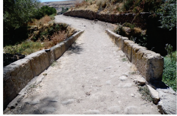
Fotoğraf 41: Yeşildere Hacı Meryem Köprüsü Döşemesi
