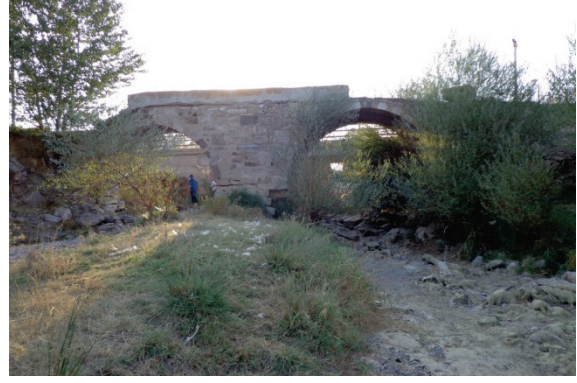
Fotoğraf 31: Hatunsaray Ak Köprü Mansap Cephesi
