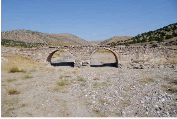
Fotoğraf 34: Gökyurt Çileder Köprüsü Membra Görünüşü
