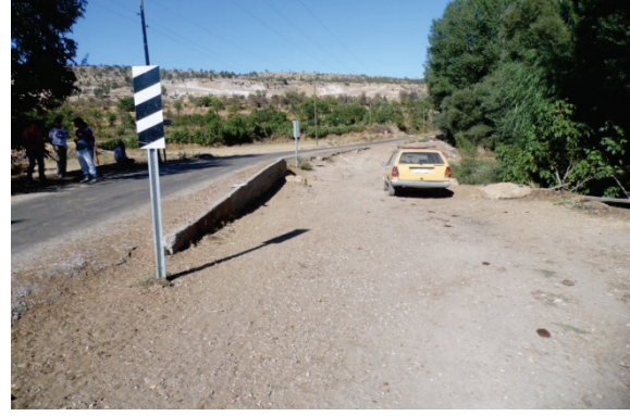
Fotoğraf 37: Yeşildere Köprüsü Döşemesi
