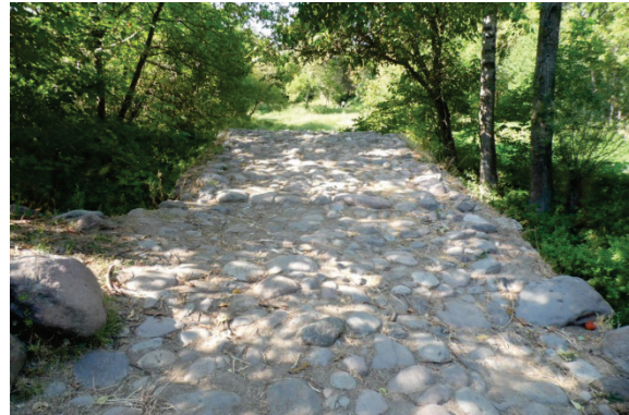
Fotoğraf 33: Gökyurt Köprübaşı Köprüsü Döşemesi
