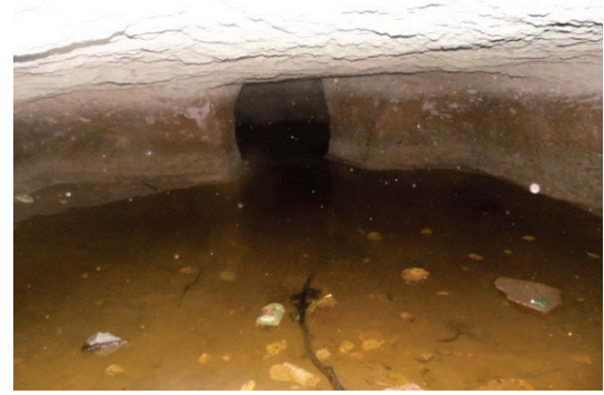
Fotoğraf 59: Evliya Tekke Köyü Sarnıcı Hazne Görünüşü
