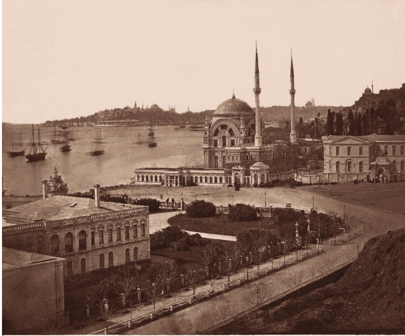
Foto. 7. Dolmabahçe Saray Tiyatrosu İnşaatı (İstanbul Araştırmaları Enstitüsü Fotoğraf Arşivi).
