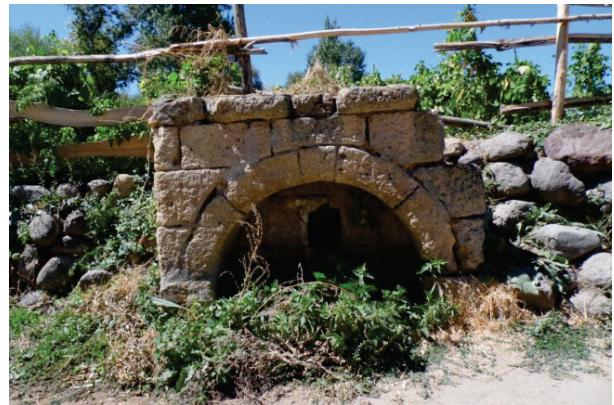
Fotoğraf 19: Yeşildere Hacı Meryem Çeşmesi Cephe Görünüşü
