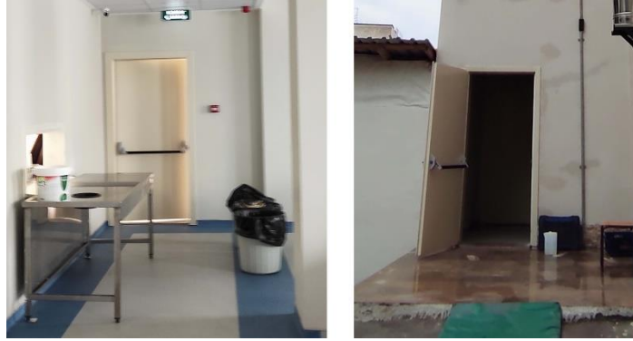
Şekil 2. Fiziksel engeller, kendiliğinden kapanma sistemlerinin eksikliği ve yangın kapılarının kapalı tutulmamasına dair örnekler
