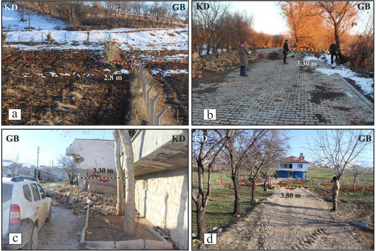
Şekil 7: Gölbaşı-Balkar arasında izlenen yüzey kırığının görünüşleri, a) Tarla sınırındaki çitte gelişmiş 2.80 m sol yanıl ötelenme ve yüzey kırığı, b) yolu 3.30 m sol yanıl atıma uğratan ve yolu deforme eden yüzey kırığı, c) evler arasında 3.30 m sol yanıl yer değışimine neden olan yüzey kırığı, d) Azaplı Gölü güneyinde stabilize yolda gelişmiş 3.80 m sol yanıl ötelenme
