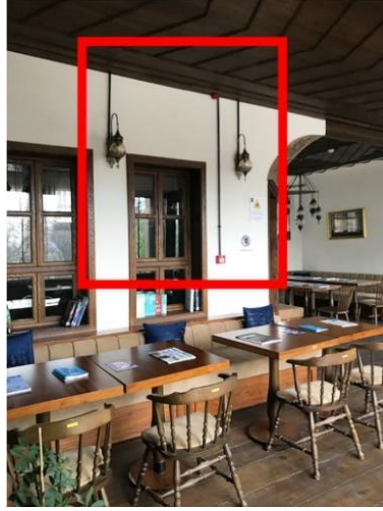
Görsel 31. 2021 Restorasyonu Sonrası Sofadaki Aydınlatmalar.
