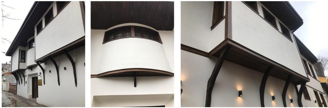
Görsel 4. 2021 Restorasyonu Sonrası Giriş (Batı) Cephesi.
