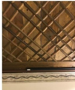
Görsel 10. 2021 Restorasyonu Sonrası Kışlık Oda Tavan Döşemesi.
