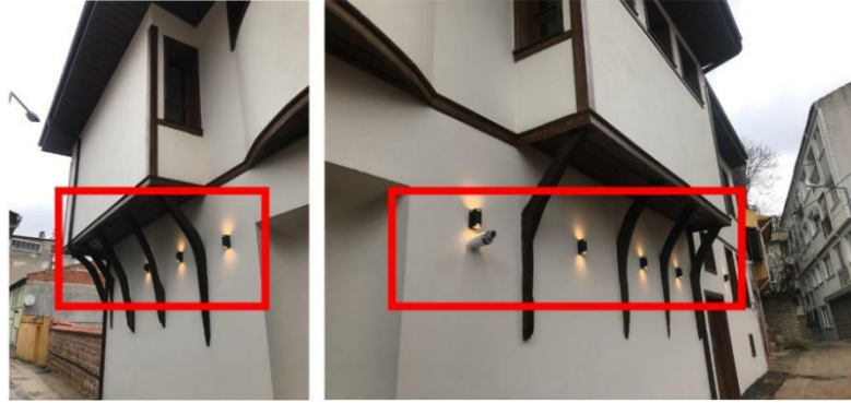
Görsel 30. 2021 Restorasyonu Sonrası Ön Cephedeki Aydınlatmalar.
