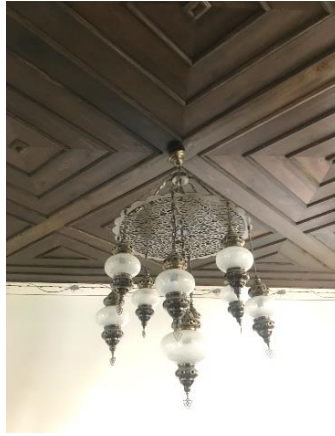
Görsel 24. 2021 Restorasyonu Sonrası Odanın Tavan Detayı.
