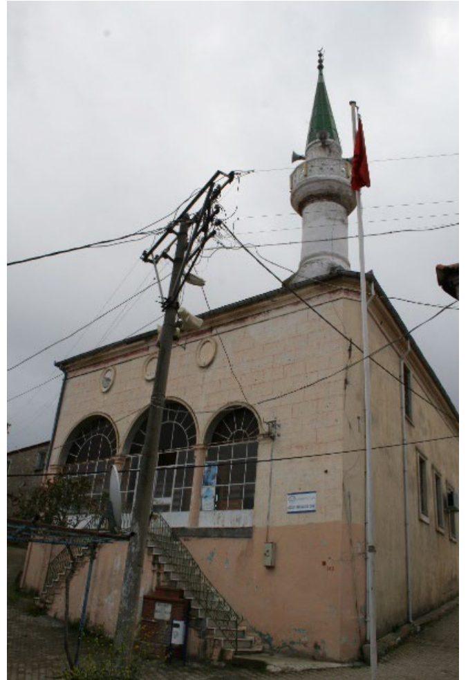
Şekil 4. Ağacık cami kuzey cepheden görünüş ve merdivenli giriş, 2019.
