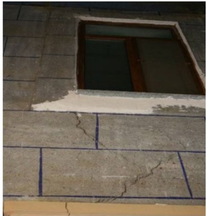
Şekil 10. Son Cemaat Yeri yeni açılan pencere ve kılcal duvar çatlakları, 2019.
