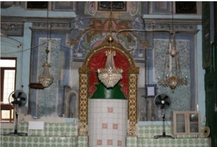
Şekil 15. Tüm cephede özellikle de mihrap nişi içinde yer alan modern seramik kaplaması, 2019.
