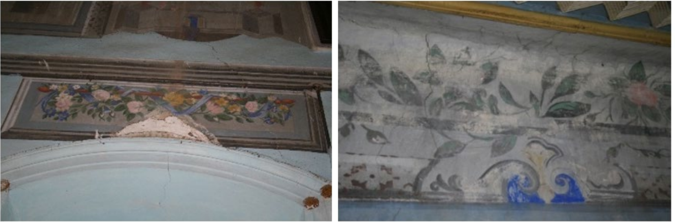
Şekil 21. Alçı işlerinde bozulmalar ve resimde tozuma ve solma, 2019.
