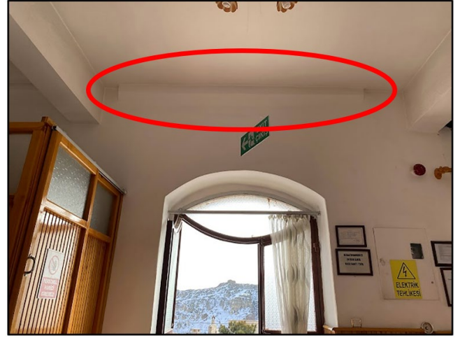
Şekil 18. Yapıda Kesilerek Özgünlüğü Bozulan Silmeler, Ürgüp, 2022.
