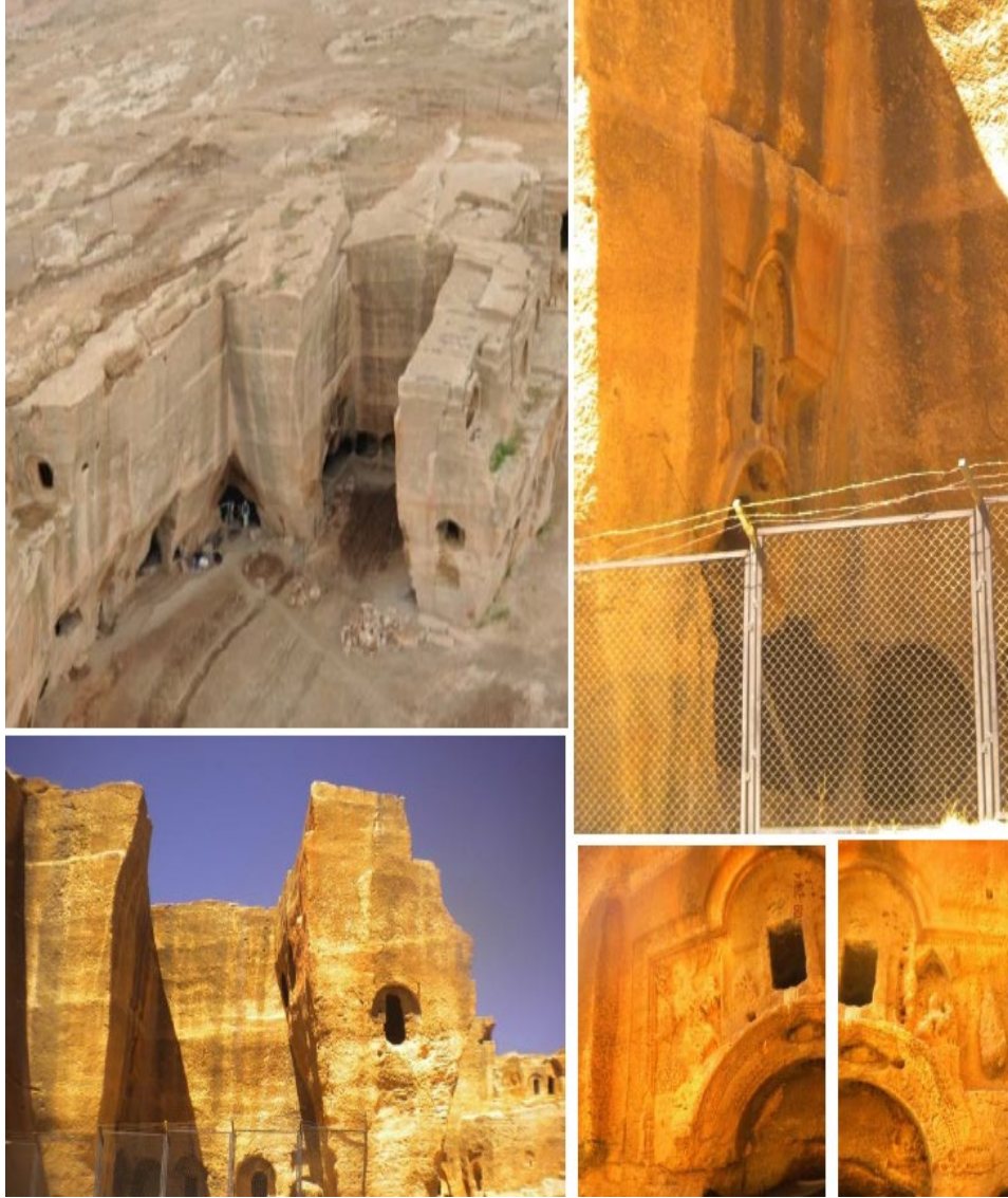
Şekil 19. a: Genel ana kaya kütle, b: Güneydoğu cephe, c: Kuzeydoğu cephe, d: e: özgün kapı kabartma detayları (Erdoğan, 2019).
