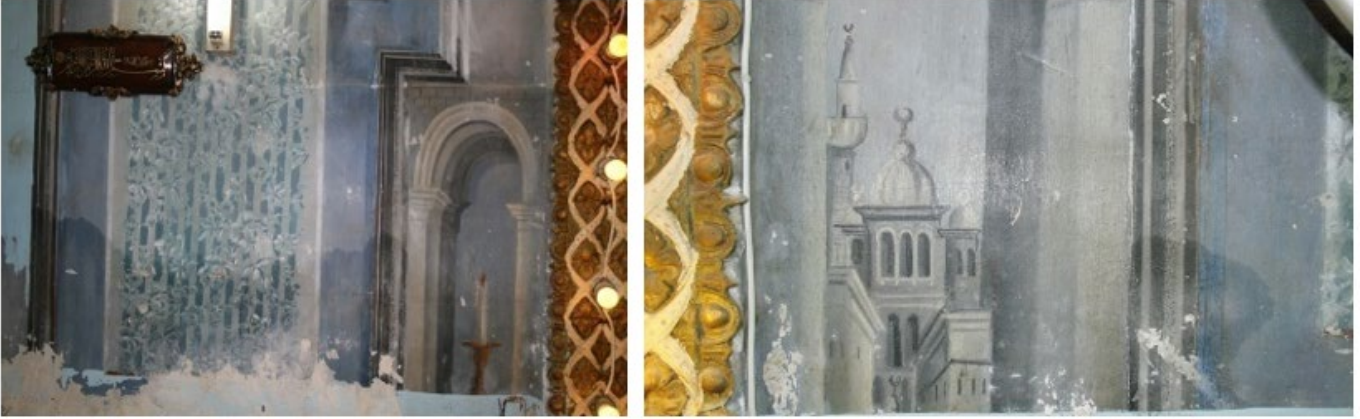
Şekil 18. Boyada nemin etkisi; kavlama ve parça kopması, 2019.
