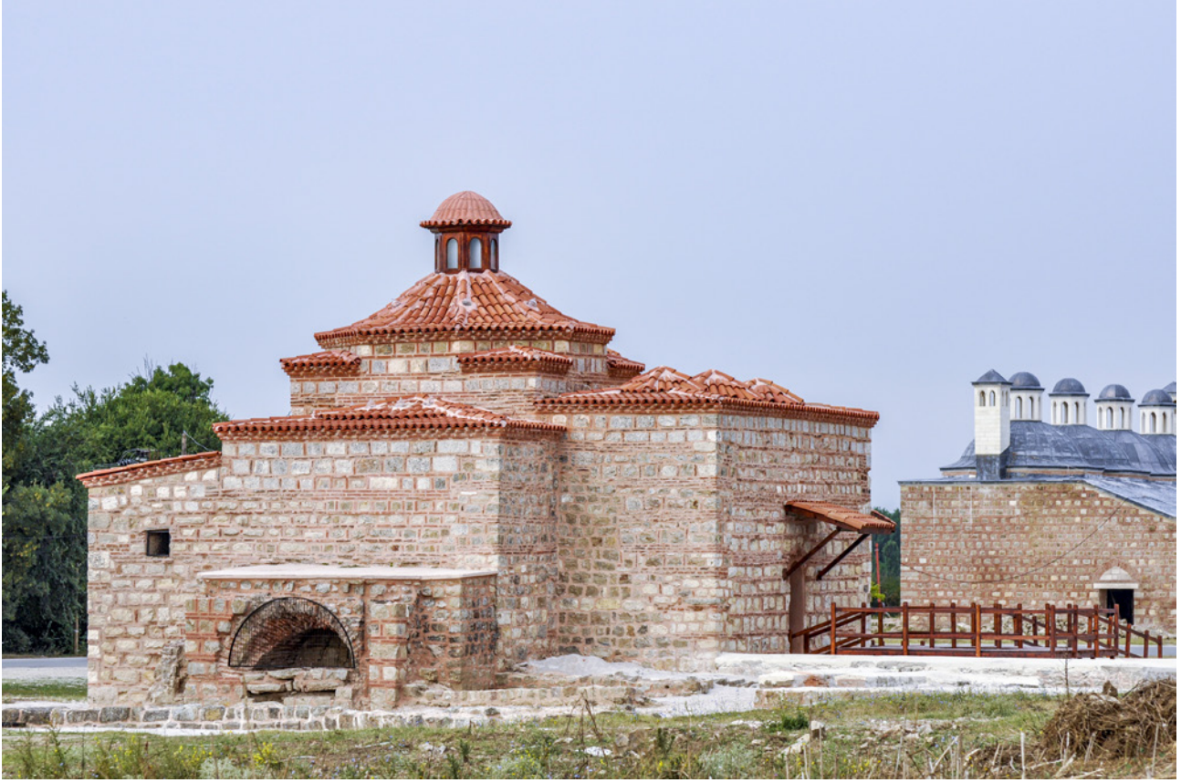
28 Edirne Sarayı'ndaki Kum Kasrı Hamamı'nın restorasyon sonrası görünümü
