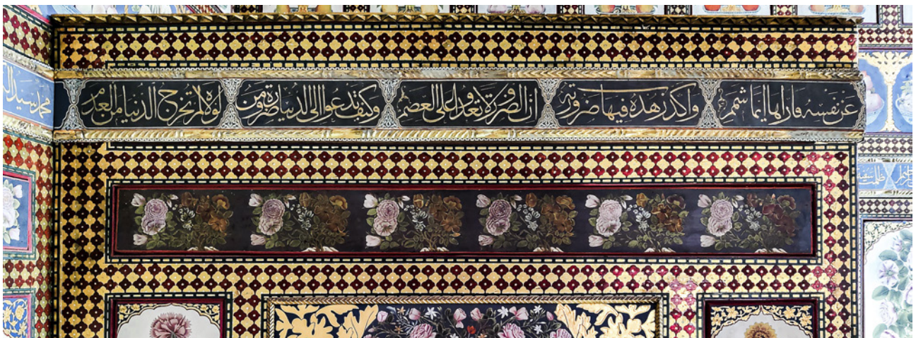
22 Yazı kuşağının restorasyon sonrası görünümü
