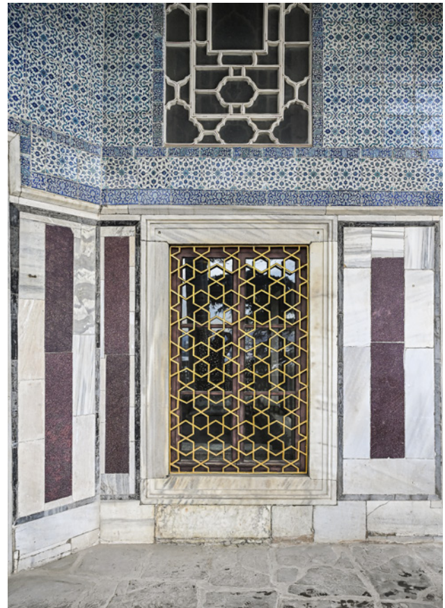
9 Bağdat Köşkü'nün batı cephesindeki mermer kaplama düzeninden detay
