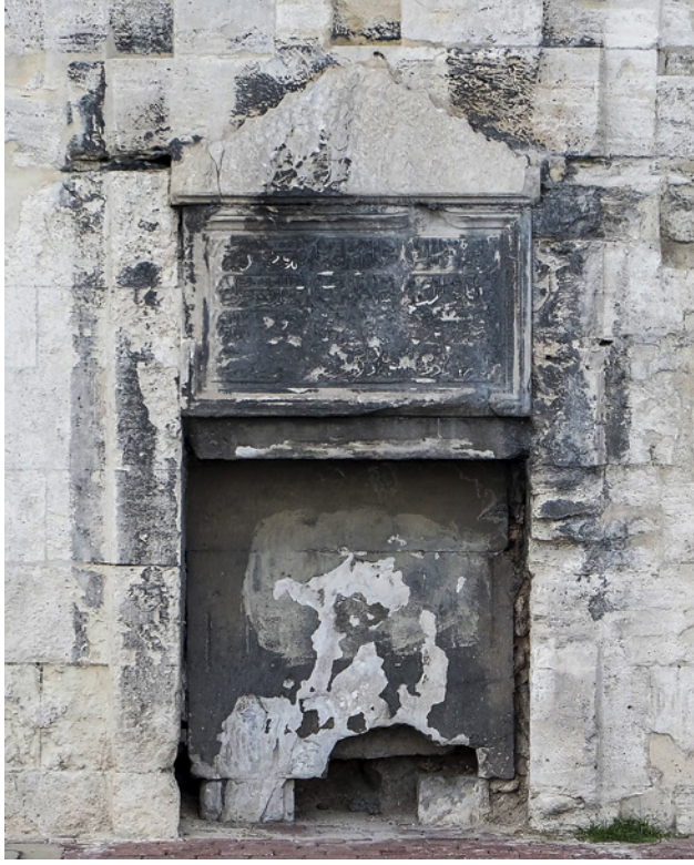
5 İncili Köşk'te bulunan çeşme
