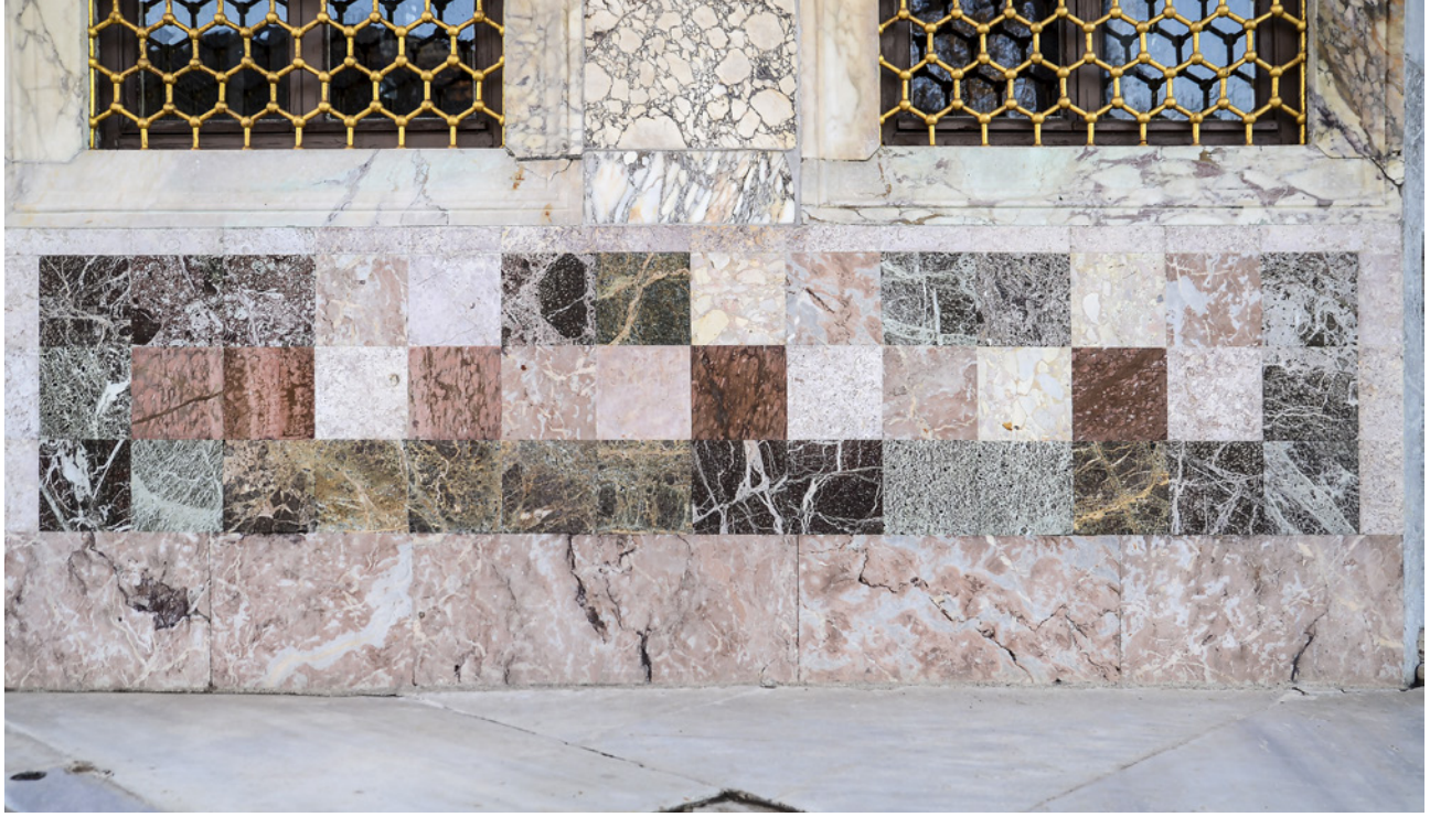
3 Revan Köşkü'nün kuzey cephesinde kare levhalar hâlinde cippollino mandolato , rosso di Francia , rosso di Levanto ile oluşturulan pano
