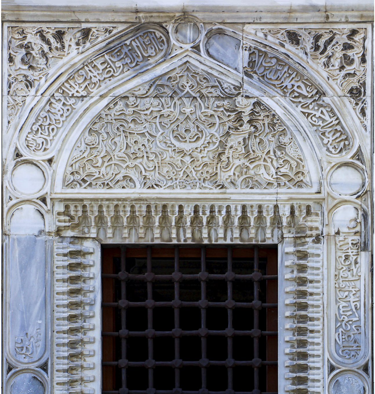
4 Yeşil Camii'nin taç kapı cephesinde tamamlanamamış pencere tezyinatı, Osmanlı dönemi, H. 822 / M. 1419, Bursa
