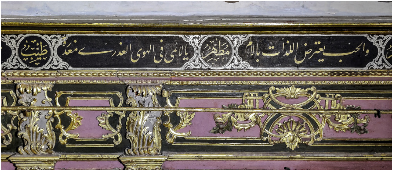
13 Yazı kuşağının restorasyon sonrası görünümü
