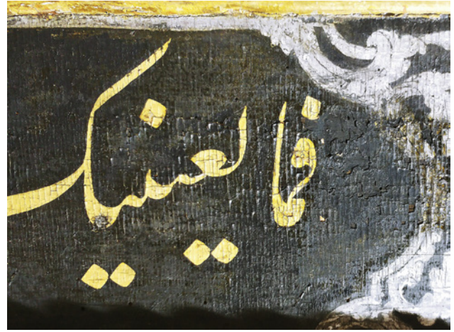
12 Çatlaklı yazı zeminlerinin tavşan tutkalı ile restorasyonu
