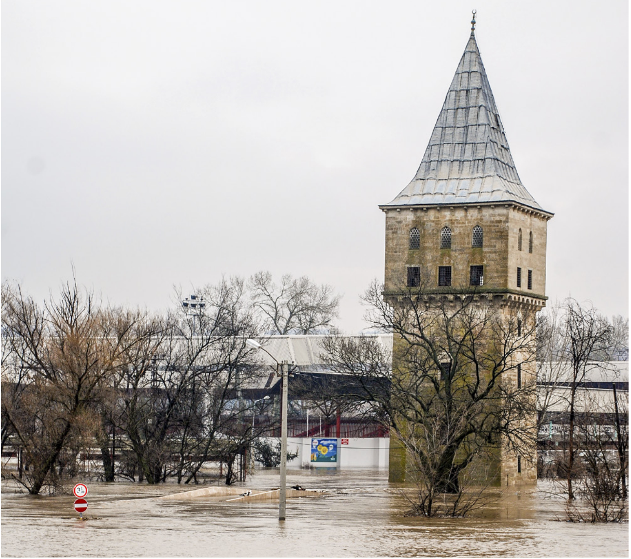
42 Tunca Nehri'nin taşması sonrası Edirne Sarayı'ndaki Kum Meydanı, Fatih Köprüsü ve Adalet Kasrı
