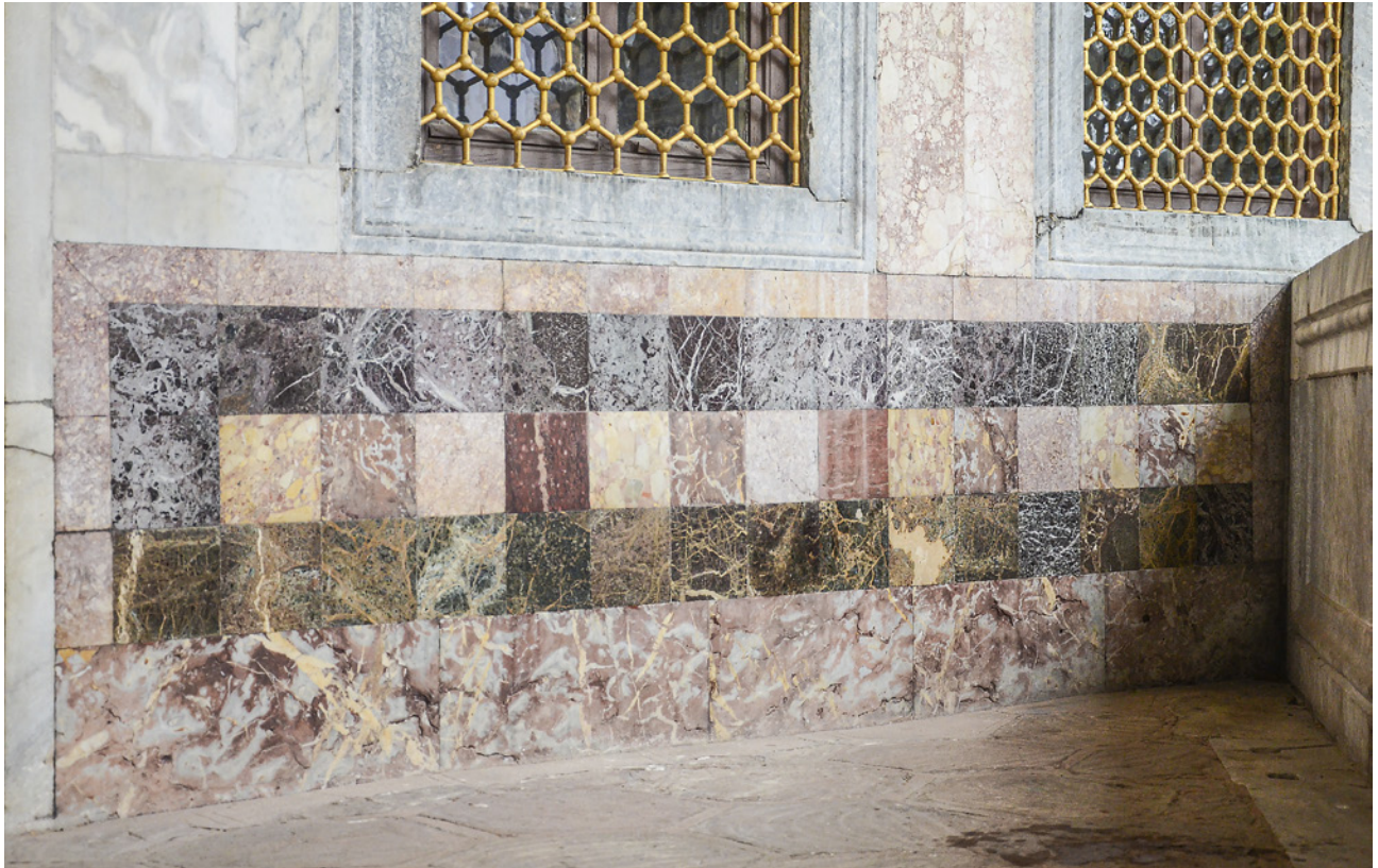
4 Revan Köşkü'nün güney cephesinde kare levhalar hâlinde brocatello , cippollino mandolato , rosso di Francia , rosso di Levanto ile oluşturulan pano
