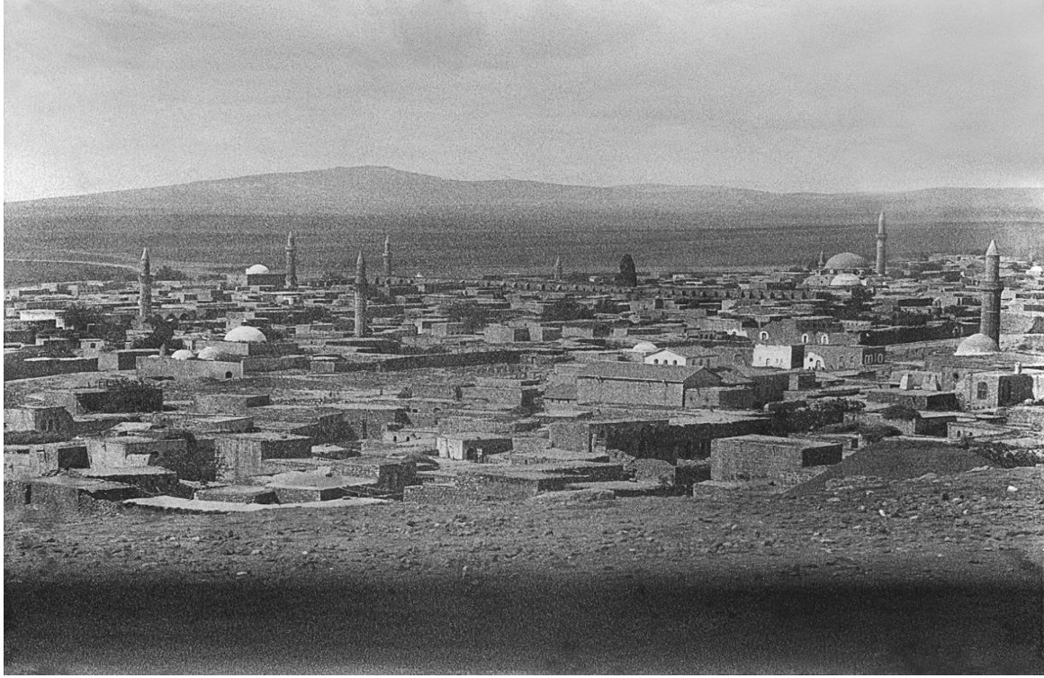
Resim 1: Kilis Şehri'nden Görünüm (Sertaç Tanıtım Arşivi)
