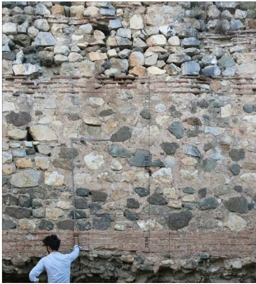
Res. 14: 105- 106 nolu burçlar arasında kalan tuğla hatıllı moloz taş duvar örgüsü.
