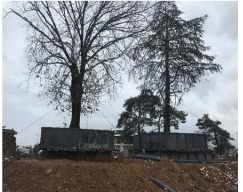
Şekil 3. 2 nolu ağacın kök bölgesinin kazılması ve 1 nolu ağacın kasa tabanının oluşturulması
