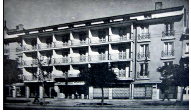
Figure 15. Nur Cinema / Nur Sineması (Arkitekt, 1952).
