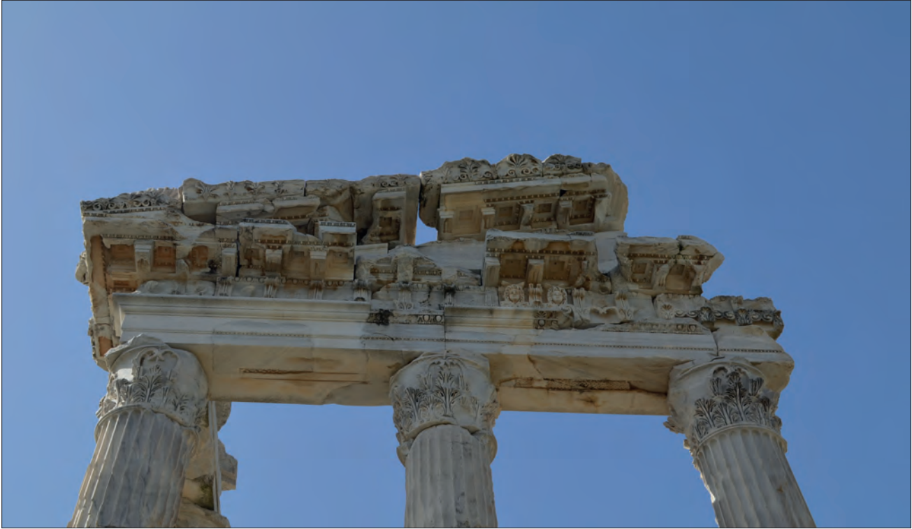
Fotoğraf 5. Kuzey alınlıkta özgün elemanlar ve süslemesiz olarak yeniden üretilmiş parçalar. Medusa başlı frizler bütünlüğün bozulmaması için Medusa başlı olarak yeniden üretilmiştir (1 Nisan 2018). / Original members on the north pediment and reproduced pieces without ornaments. Medusa-headed friezes were reproduced as Medusa-headed in order to preserve the integrity (April 1, 2018).
