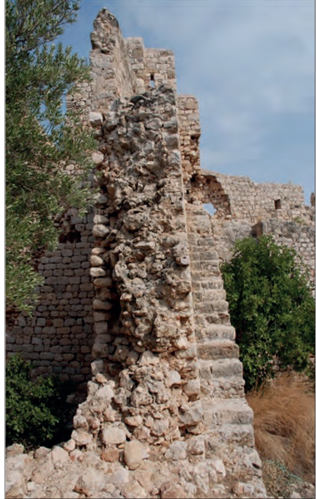
Fotoğraf 25. Batı duvarı detayı / West wall detail. (E.S. Cesur, 2009)
