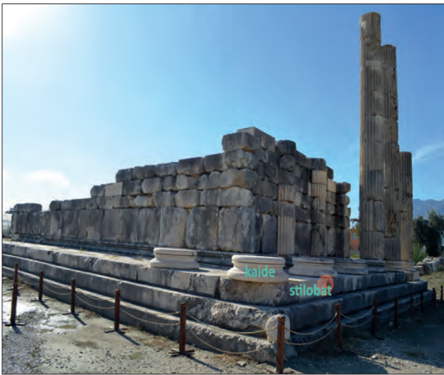
Fotoğraf 7. Yüksek oranda özgün malzemeyle ayağa kaldırılmış kuzeybatı köşedeki üç sütun ve yeni malzemeyle üretilmiş sütun kaidesi ve stilobatlar (28 Ekim 2017). / The three columns in the northwest corner, which were re-erected with a high percentage of original materials, and the column bases and stylobates reproduced with new materials (October 28, 2017).
