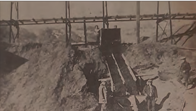
Fotoğraf 3. Kömürü üst kottaki harman alanından alt kottaki tekerlekli taşıta aktaran oluk sistemi (Çıladır, 1934, s. 34) / The telegraph system which transports the coal from the blend area in the upper level to the wheeled transport in the lower level (Çıladır, 1934, p. 34)
