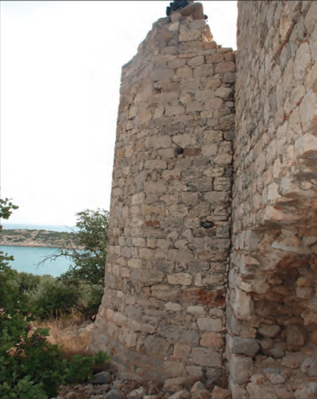
Fotoğraf 29-30. E Burcu üzerinde ahşap hatlı delikleri (Doğudan bakış) / Wooden beam holes on Bastion E (East view). (E.S. Cesur, 2009)
