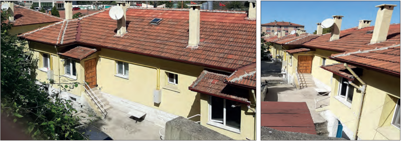
Fotoğraf 14. Çift lojman yapılarının güney cephesinden görünümü (Fotoğraflar yazarlar tarafından çekilmiştir, Eylül 2022) / View of the semi-detached lodgements from south façade (Photos were taken by the authors, September 2022)
