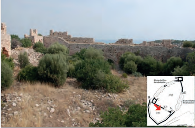
Fotoğraf 5. Güney avlusu (iç) / South courtyard (interior). (E.S. Cesur, 2009)
