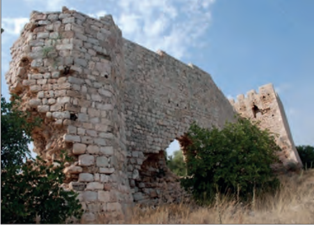
Fotoğraf 12. Kuzey duvarı dış görünüş / North wall exterior (E.S. Cesur, 2009)
