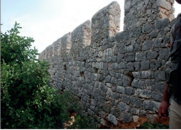
Fotoğraf 23. Avlu duvarı, kuzey / Courtyard wall, north. (E.S. Cesur, 2009)
