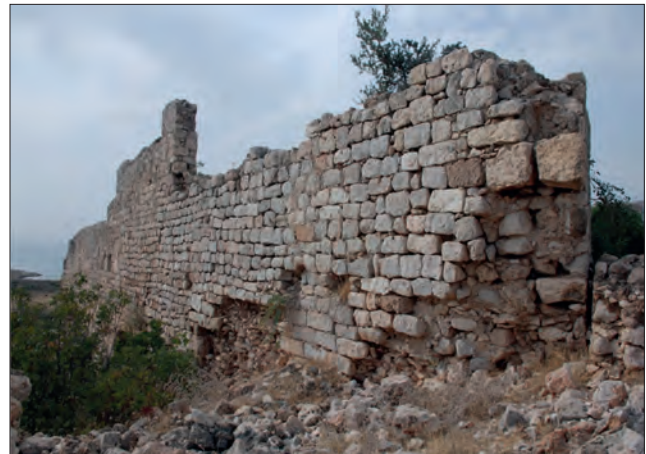
Fotoğraf 26. Doğu duvarı yapım tekniği detayı / Detail of the construction technique of the eastern wall. (E.S. Cesur, 2009)
