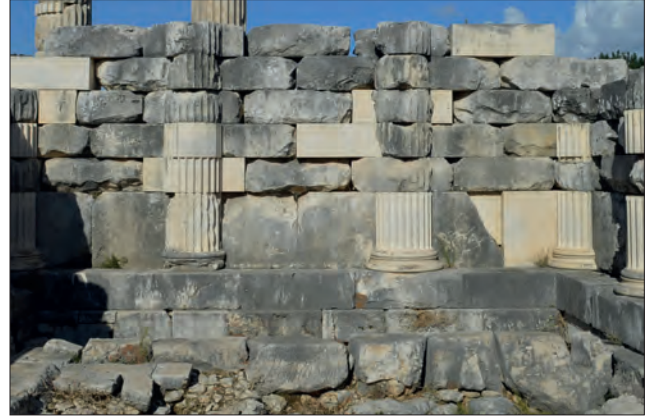
Fotoğraf 8. Sella kireçtaşından yeni üretilen bloklar (28 Ekim 2017). / Newly produced blocks from limestone in the cella (October 28, 2017).
