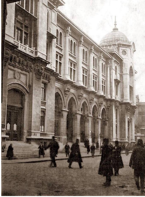
Şekil 29 1909 yılında İnşaatı tamamlanan Posta ve Telgraf Nezareti Binası
