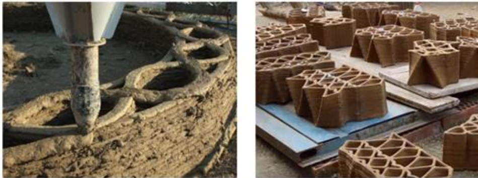
Şekil 20. İtalya'da kerpiç malzeme kullanılarak katmanlı imalat ile üretilen köy evi (Çalışkan vd., 2020) Figure 20. Village house produced with additive manufacturing using mud brick material in Italy (Çalışkan et al., 2020)
