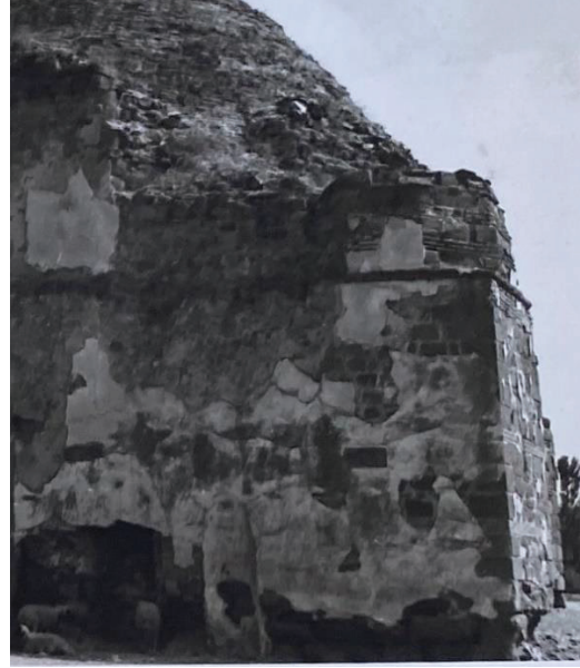
Görsel 26-27. Ergülü Baba (Sahra) Camisinin batıdan minare gövde ve papucu (26) ile kuzey cephe ve minare (27) uyumsuzluğu (1992 Vakıflar Genel Müd. Arşivi)
