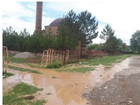
Görsel 11. Yağmur sonrası yapının yaşadığı tehlike
