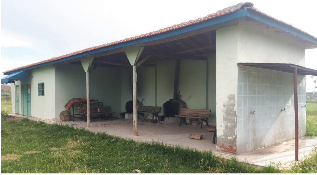
Görsel 8. Kurban kesim, pişirim binası (aşevi)
