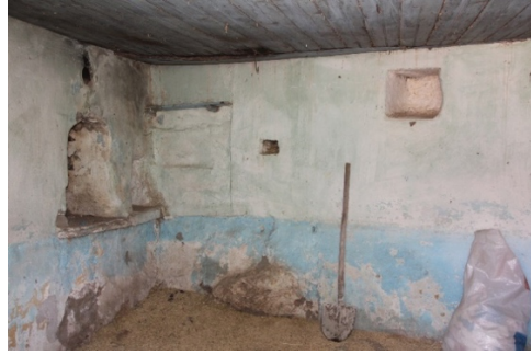
Resim 10. Kıraathane iç mekanının günümüzdeki görünüşü (Eken Güney, 2017)
