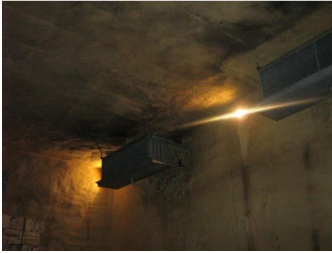
Şekil 5. PU köpük malzemesinde meydana gelen kararma ve deformasyonlar Figure 5. Darkening and deformations occurring in PU foam material
