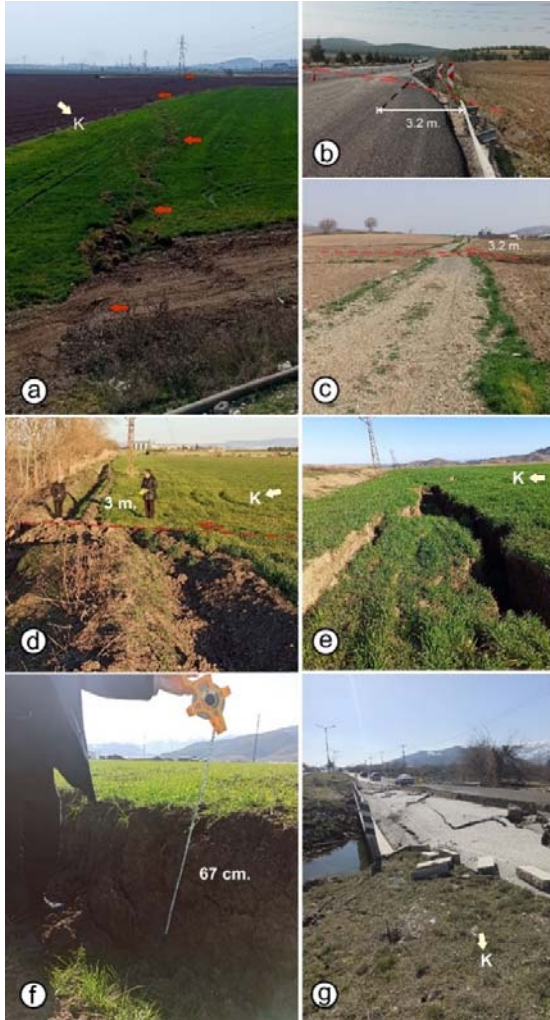
Şekil 9. DAF boyunca gözlenen önemli yüzey deformasyonları a,b,c) Çiğli civarında gözlenen yüzey yırtıkları ve yanıl ötelenmeler; d) Türkoğlu Şihağalar civarında gözlenen 3 m. sol yanıl ötelenme; e) Beyoğlu Yeni mah. Civarından yüzey yırtılmasının izi ve oluşan düşey atımlar, g) Şekeroba civarında bir kanal köprüsü üzerinde meydana gelen deformasyon.
