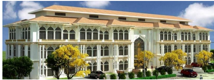
Fotoğraf 16. Musabeyli Hükümet Konağı (Musabeyli Kaymakamlığı, http://www.musabeyli.gov.tr/yeni-hukümet-konağı-binasi adersinden 16.02.2022 tarihinde erişilmiştir)
