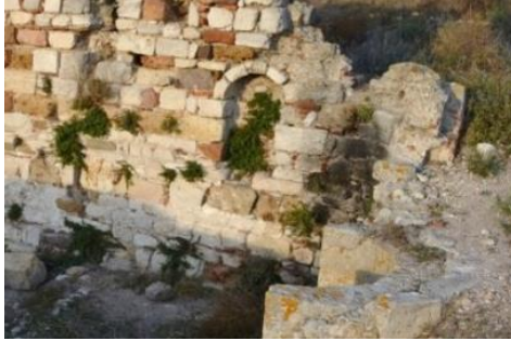
Şekil 39. Kuzey duvarındaki kemerli niş (2014)
