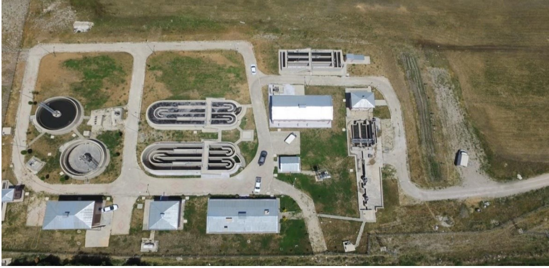
Şekil 2. Gevaş evsel atıksu arıtma tesisi (Durak, 2020).
