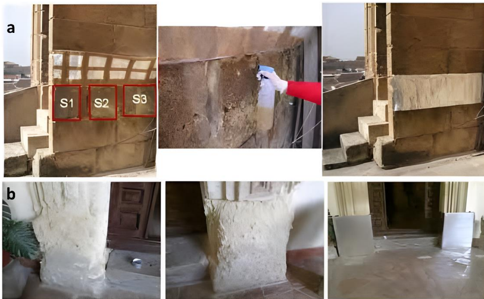
Şekil 4. San Jeronimo Manastırı'nda yerinde yapılan biyo-sağlamlaştırma; a: Şapel, b: Avlu Kapısı (Jroundi ve ark, 2010)
