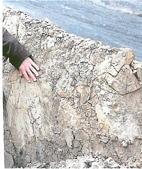
Şekil 3. Dolusavak kazı şevlerinin derivasyon tüneli çıkışına yakın bölgedeki hareketleri ve yakın planda ezilme zonu
