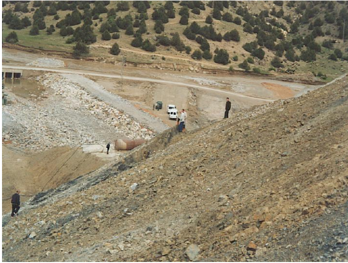
Şekil 3. Dolusavak kazı şevlerinin derivasyon tüneli çıkışına yakın bölgedeki hareketleri ve yakın planda ezilme zonu
