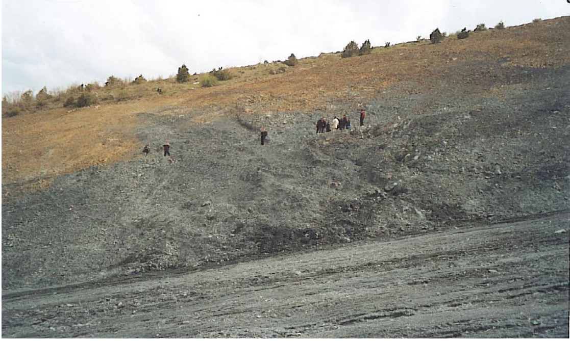
Şekil 2. Derivasyon tünelinin çıkış ağzına yakın bölgede meydana gelen zemin hareketi
